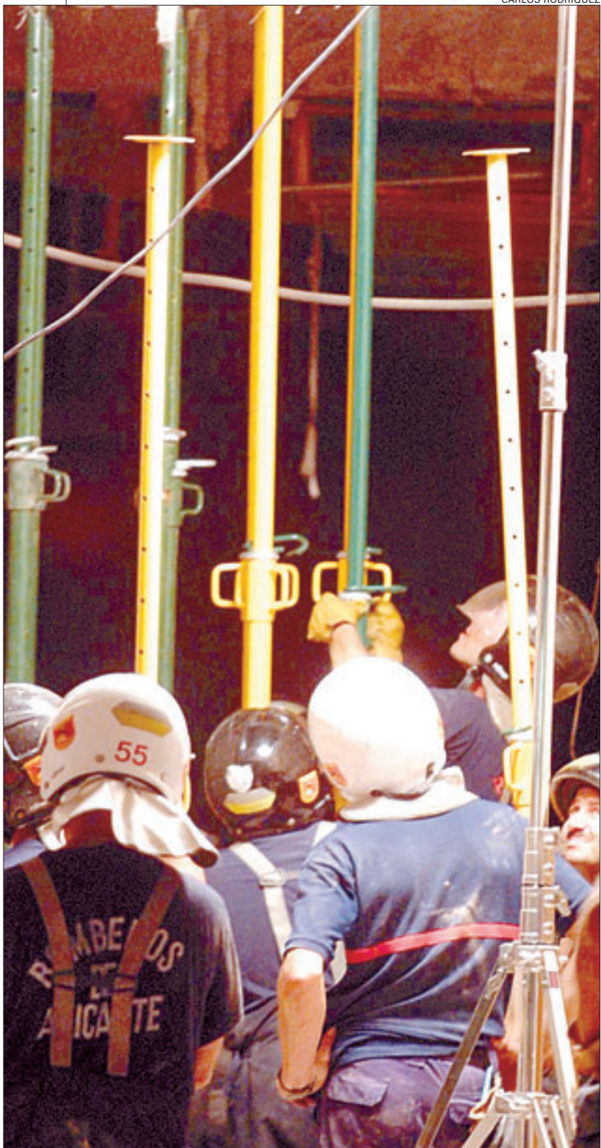
derecha, funcionarios de Alicante apuntalan la planta baja del edificio del hotel Bahía
