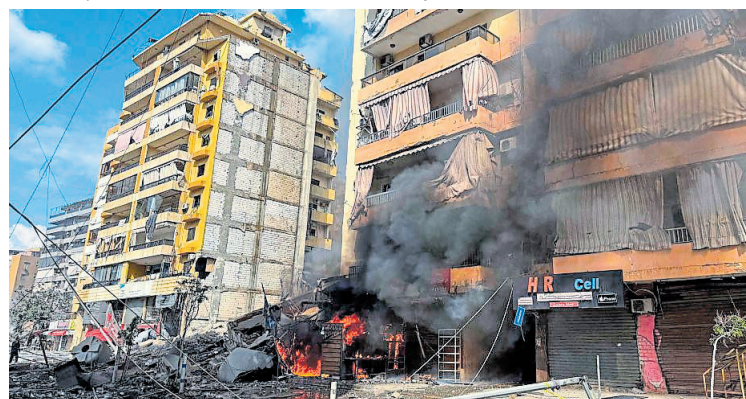
Llamas y humo en un edificio residencial de Beirut.
