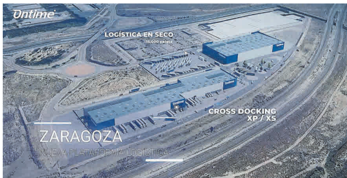
Plano aéreo del nuevo complejo de Ontime en el parque empresarial Puerta Norte, donde se construirán dos naves logísticas.
