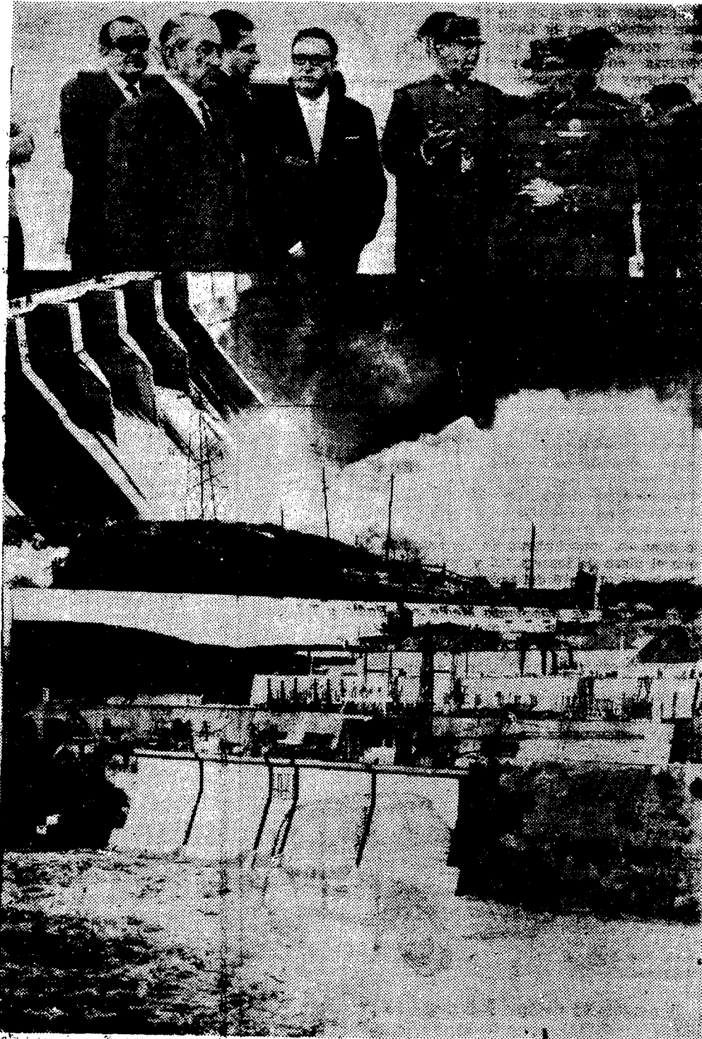
Ofrecemos el testimonio gráfico del grave accidente ocurrido el viernes en la Presa de Torrejón, al averiarse una ataguía, con la consiguiente inundación. Arriba las autoridades encabezadas por el gobernador civil, que inmediatamente se trasladaron a la presa. En el centro, salida de las aguas por la compuerta superior y, abajo, la zona del túnel inundado, donde se aprecia la subida del nivel de las aguas (Fotos Enrique G.)
