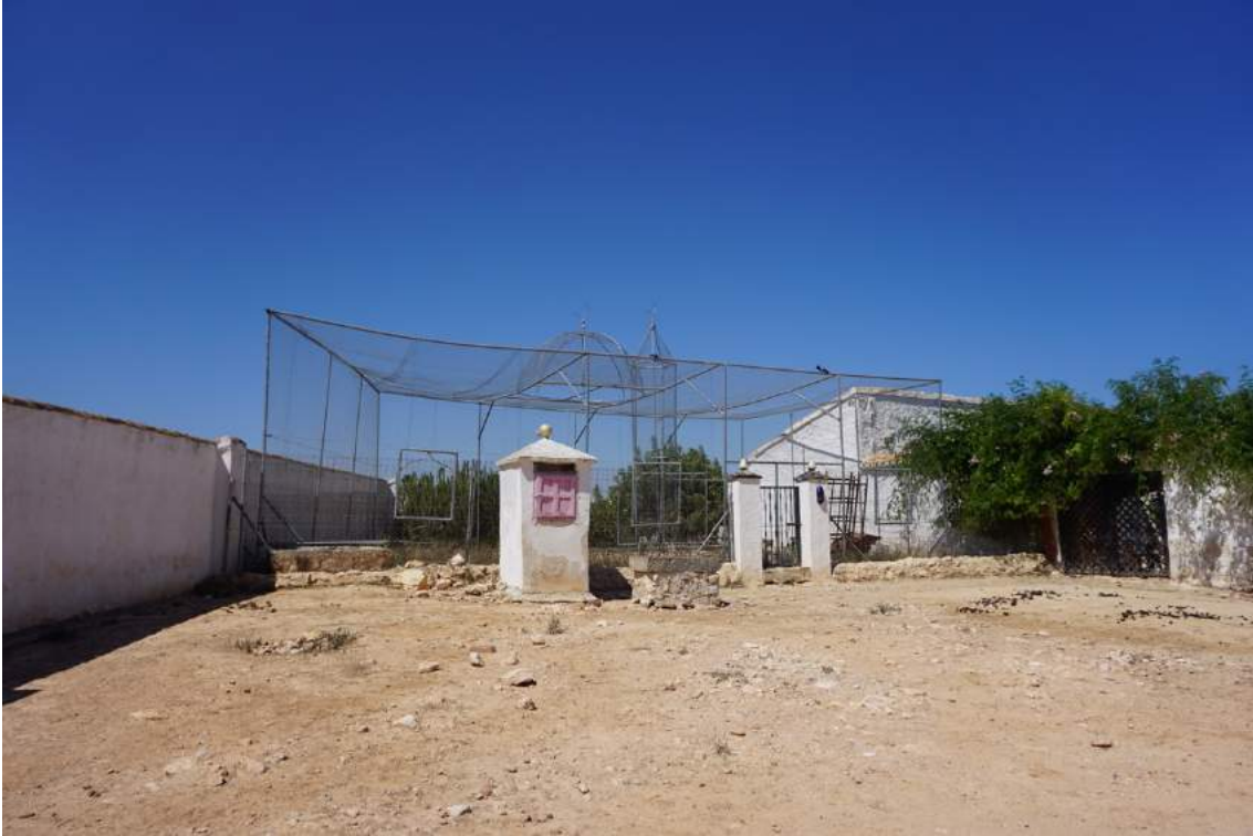
Figura 9. De izquierda a derecha se identifica pozo de decantación, brocal de aljibe y abrevadero. Elaboración propia.
