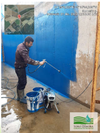
Fotografía de la aplicación de la pintura anti-fouling en la CRT-Z
