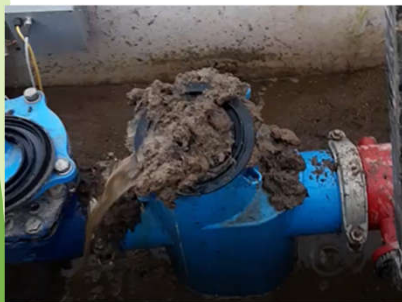
Hidrante desaguando briozoo en la CRT-Z
