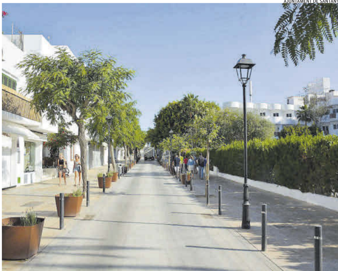
Les obres d'embelliment del carrer Boulevard de Cala d'Or ja estan acabades.
