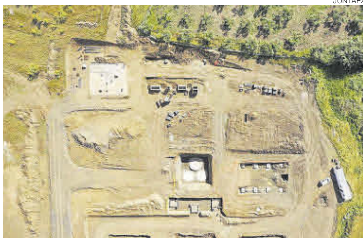
►► Obras de la estación depuradora.
