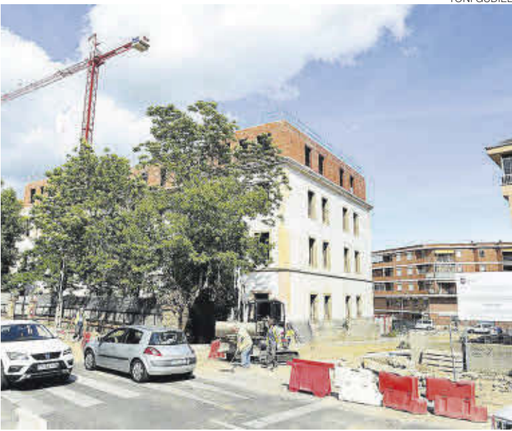
►► Vista de las obras de la calle, junto a los pabellones.
